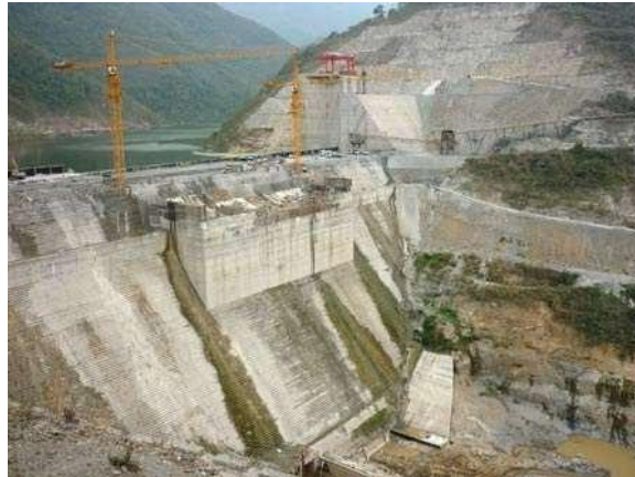
Xây dựng các công trình thủy điện
